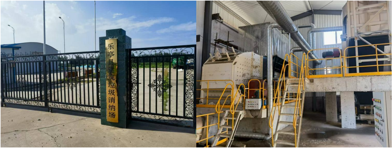
图 2-5 乐亭县建筑垃圾消纳场现场实景图
