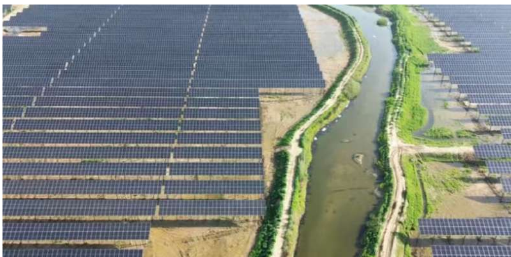
图 2.2-4 固定式安装方式
