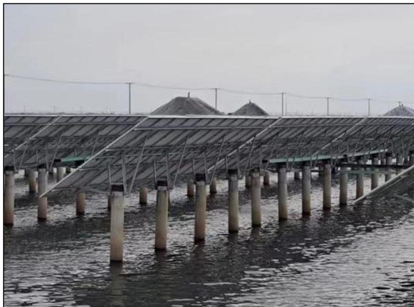
图 4.1-2 桩基式光伏阵列示意图
