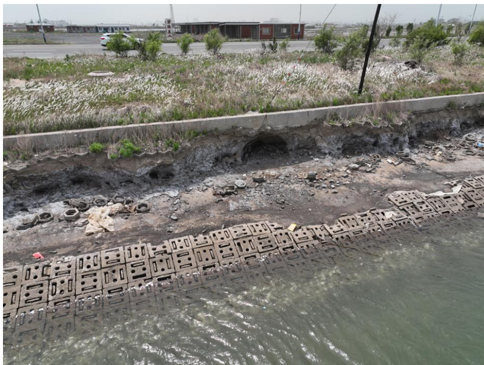
图 10 老米沟河口岸线踏勘点 2 北侧护岸拍摄图
