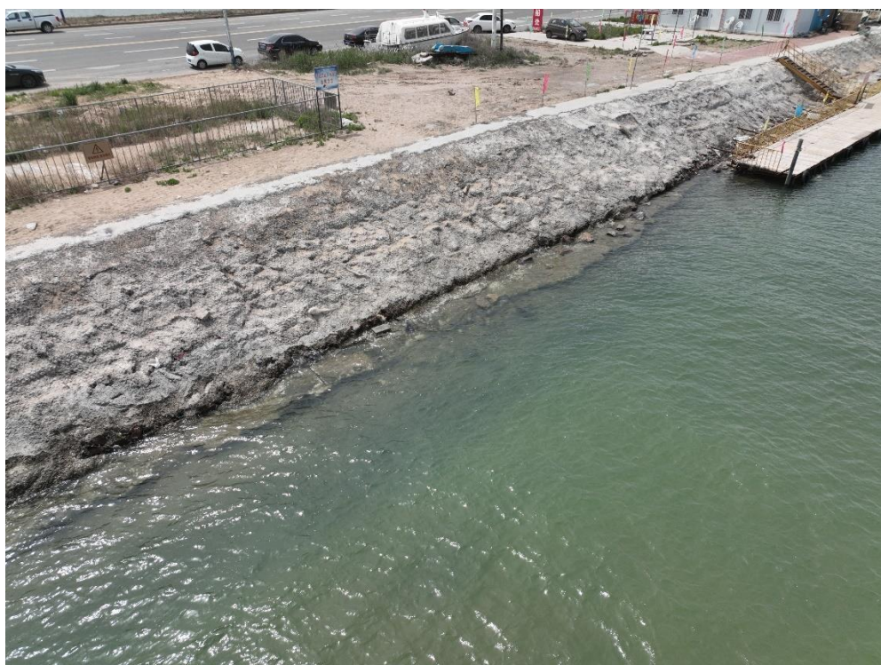
图 9 老米沟河口岸线踏勘点 2 护岸拍摄图
