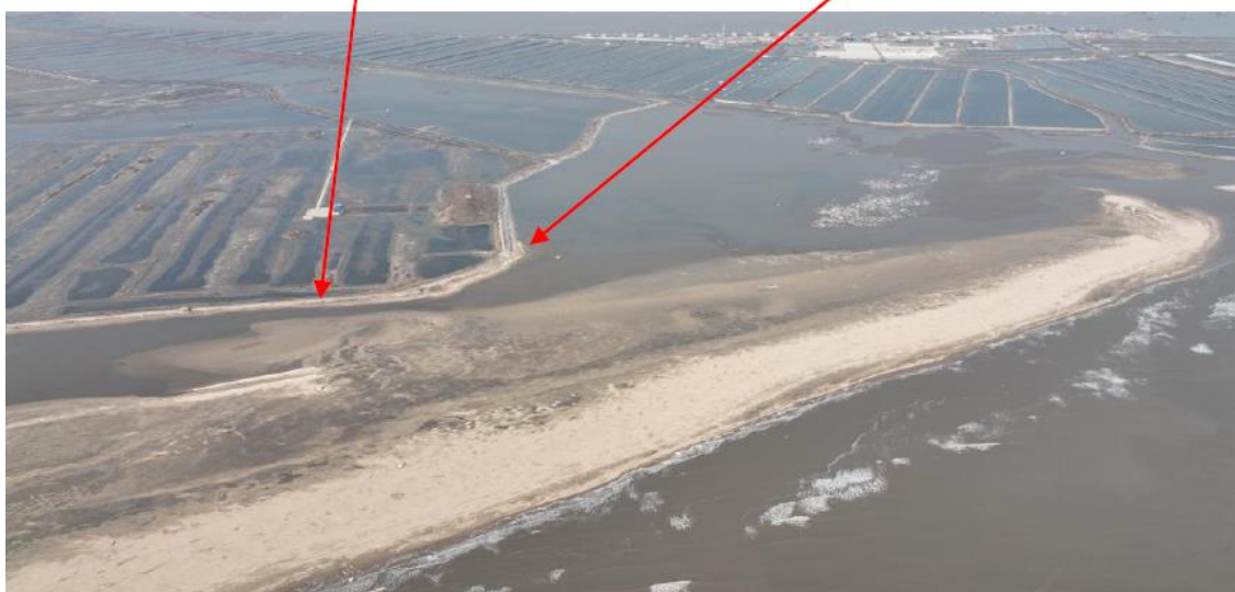
图 1.3.1-10 靶场岸段岸线垃圾现状
