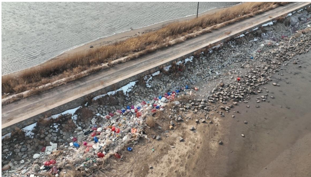
图 4 靶场岸线踏勘点位 1 东侧海堤拍摄图
